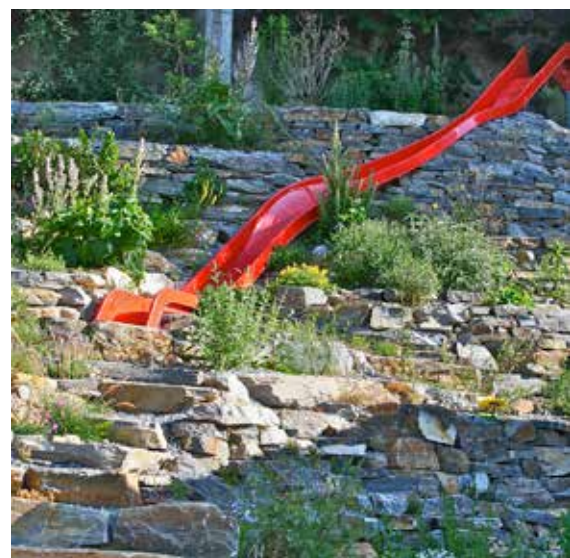
Oben links: Unbehaufene Juarakalksteine in einer formwilden Trockenmauer mit Treppe in einem Privatgarten in Delémont (JU). Oben rechts: xxx. Unten links: xxx. Unten rechts: xxx.
